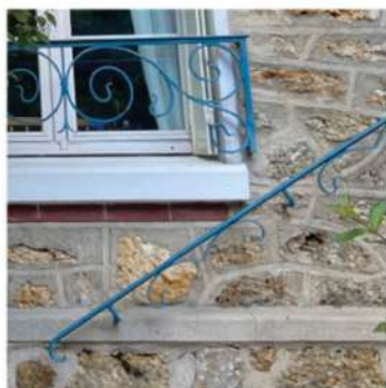
garde-corps et main courante en fer forgé avec dessin art-déco état apparent : ++
